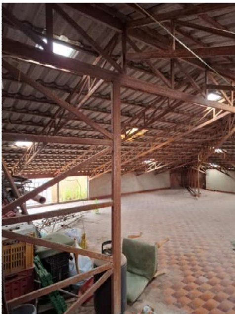
FOTO N.32 – TERRAZZA PIANO SECONDO
