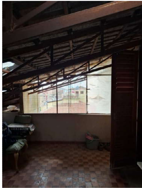
FOTO N.31 – TERRAZZA PIANO SECONDO
