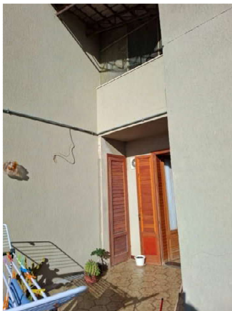
FOTO N.27 – TERRAZZA PIANO PRIMO
